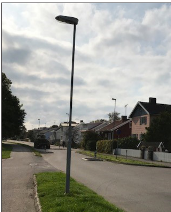
Gamla Göteborgsvägen har fartdämpande åtgärder.
