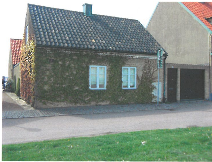
Bild 3. Mindre påbyggnad är möjlig på garagebyggnad
