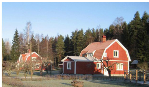
samt Järpetan 1:30 och 1:29 är av kulturhistoriskt intresse.
