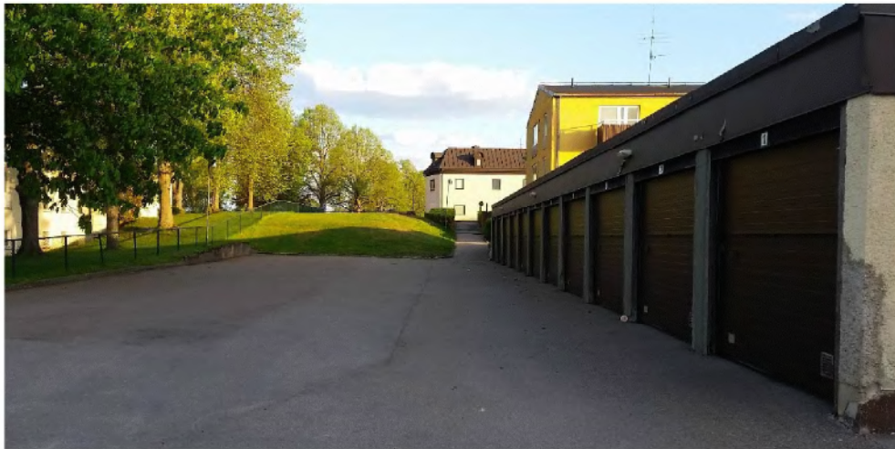
En garagebyggnad samt tre bilparkeringsytor på mark finns inom fastigheten Ankaret 2.
