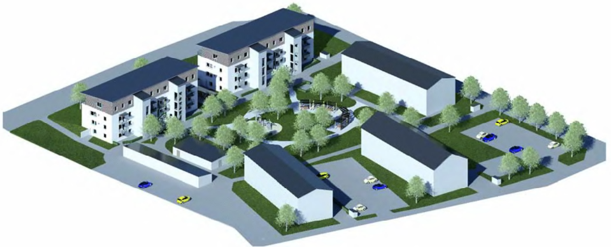
Bilden visar möjlig utformning av bostadshusen med en påbyggd våning samt påbyggda trapphus. Illustration av Sonark Arkitektkontor.
