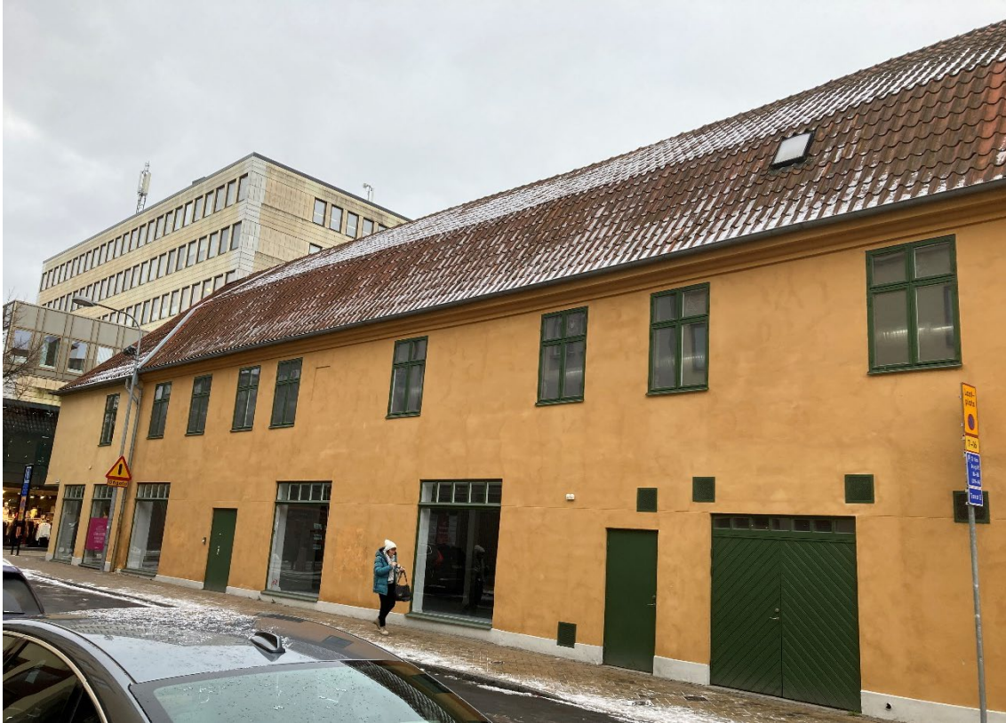
Bild 9. Snapphanen 16 utmed Östra Vallgatan. Foto taget mot fastigheten Stenbock 3 i norr och visar takets-, fönstrens- och fasadens utformning. På fotot syns också befintligt takfönster på mansardtaket. Foto taget 7 december 2021 av Rebecka Danielsson.
