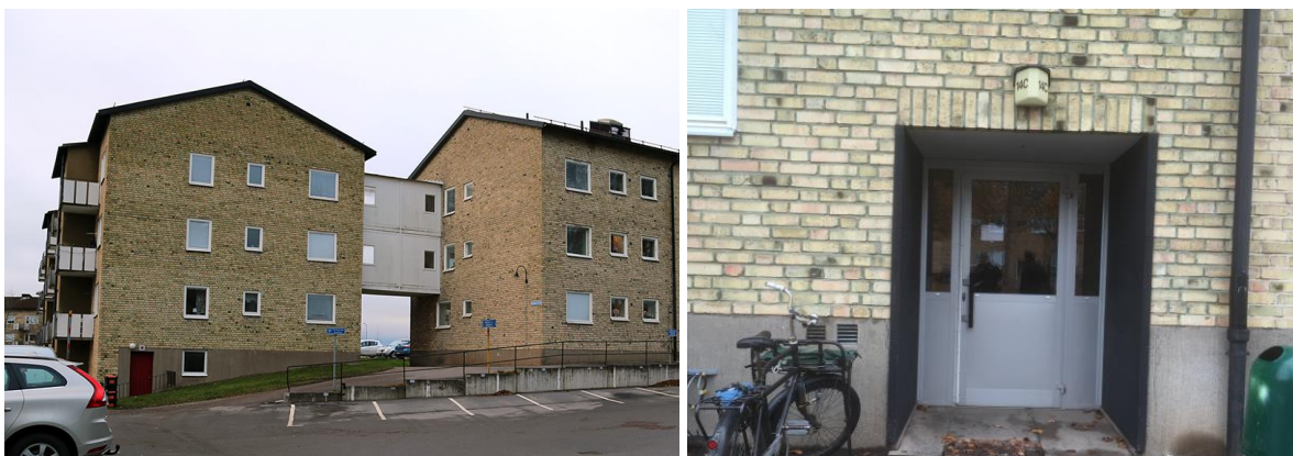
Till vänster: Sammanbyggda huskroppar. Till höger detalj bostadsentré. Föglulörerna varierar vilket skapar en variation i fasaden.
