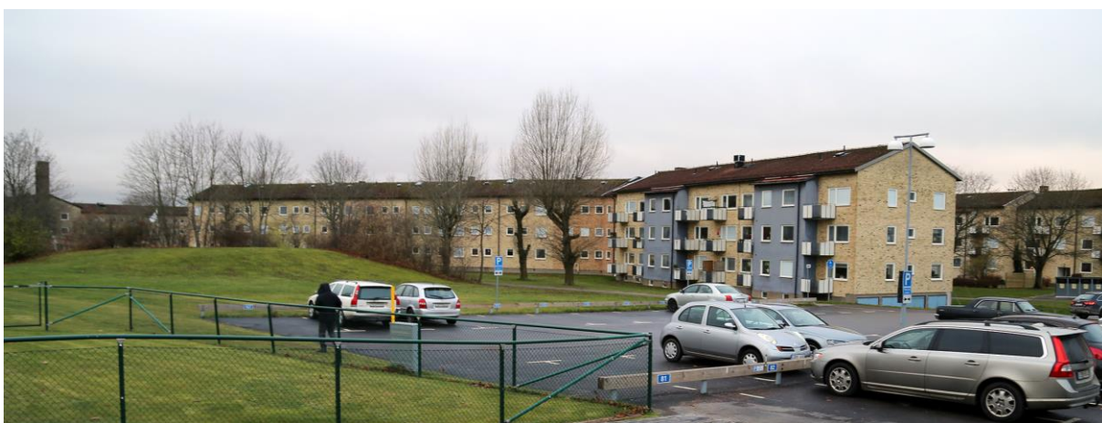
Planområdet sett från norr (Medevivägen). Befintlig markparkering i förgrunden.
