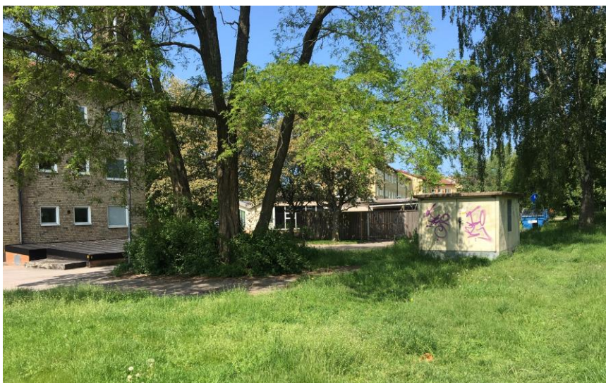
Grönyta och transformatorstation.
