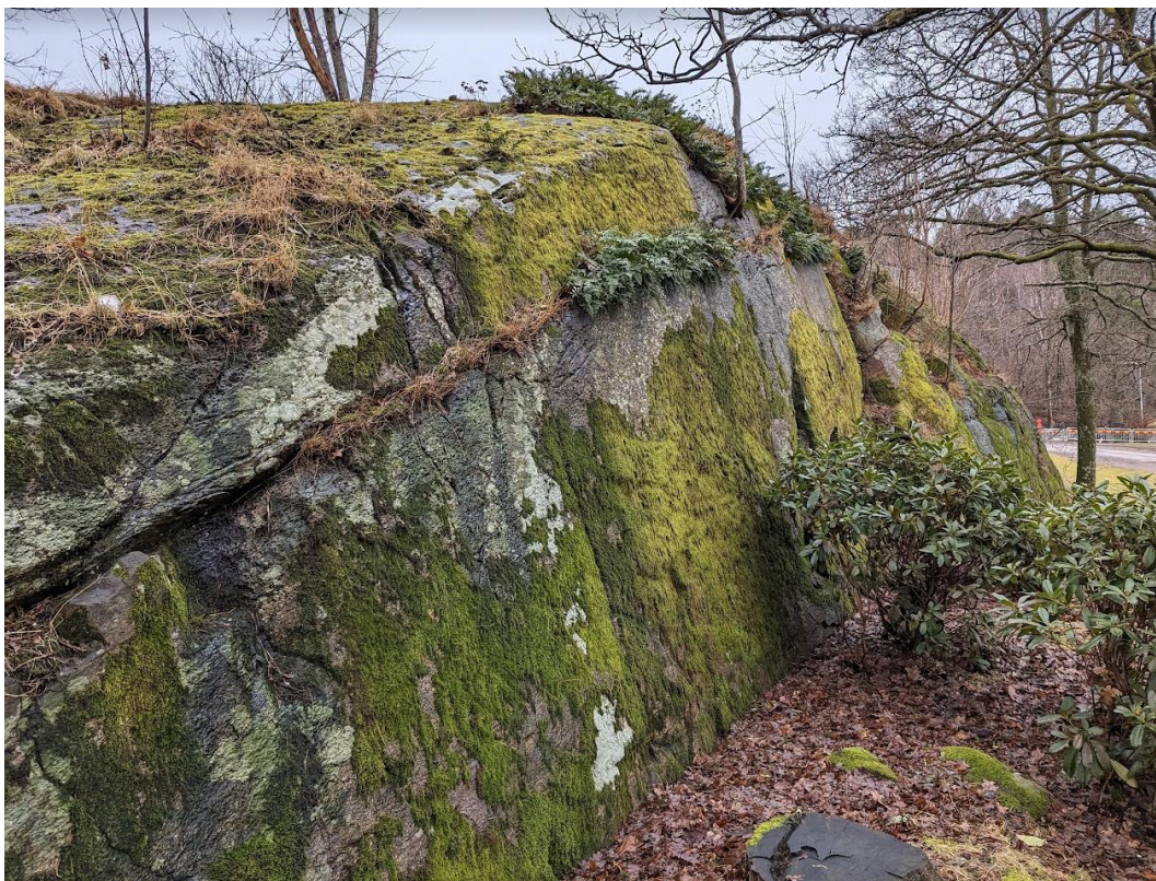
Foto 7. Nordöstra bergslänten, berget är homogent och sprickfattigt, bild tagen i sydlig riktning.
