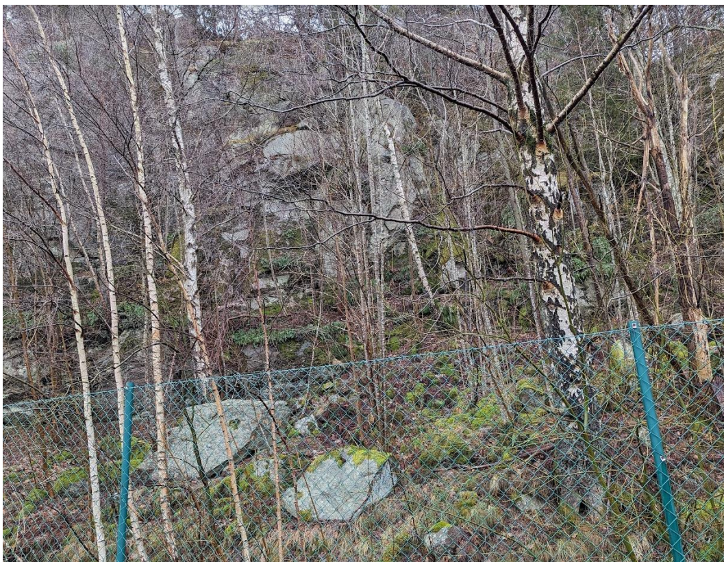
Foto 3. Kraftig vegetation framför och i hög slänt vid den södra bergslänten, fåtal lösa block vid släntfot, bild tagen i sydöstlig riktning.
