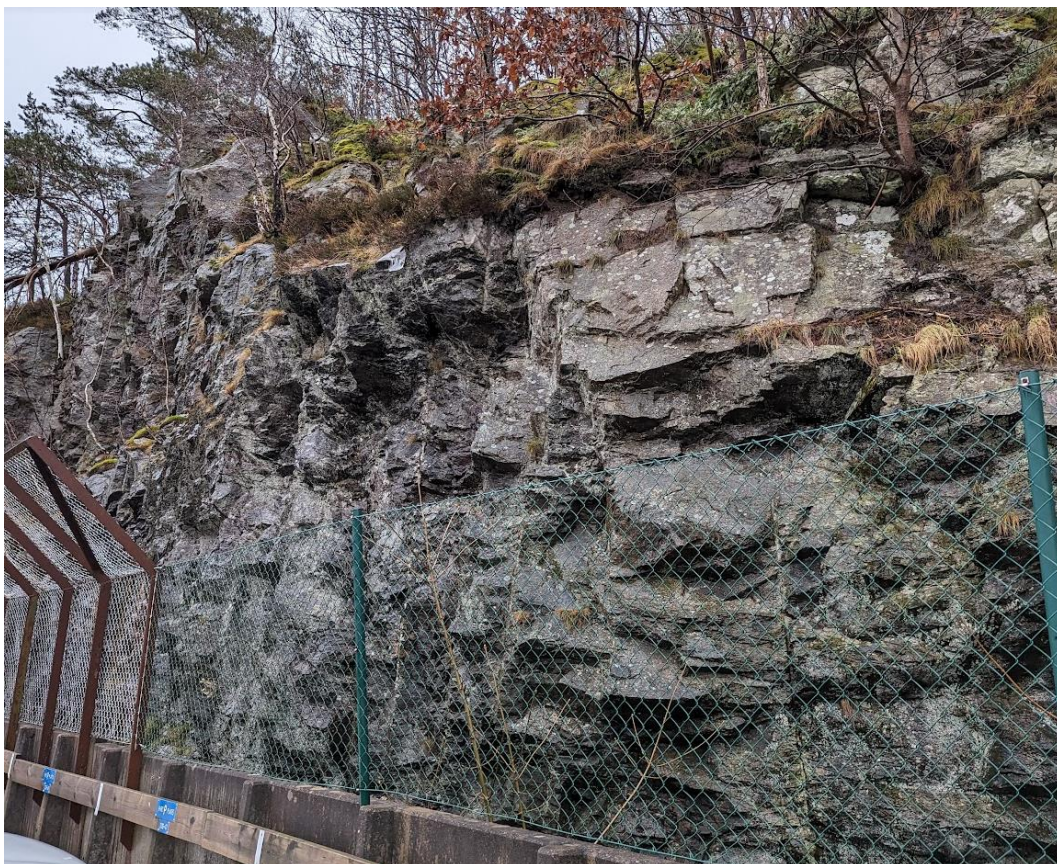
Foto 1. Södra bergslänten, syd. Småblockigt berg i nära anslutning till parkeringsgarage, bild tagen i sydöstlig riktning.
