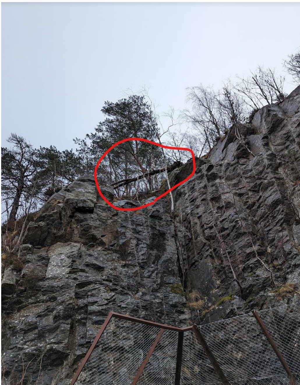
Foto 4. Den norra delen av södra bergslänten. Inga lösa block kunde noteras men träd växer i och på slänt. Nedfallet träd vid släntkrön markerat i rött. Bild tagen i östlig riktning.
