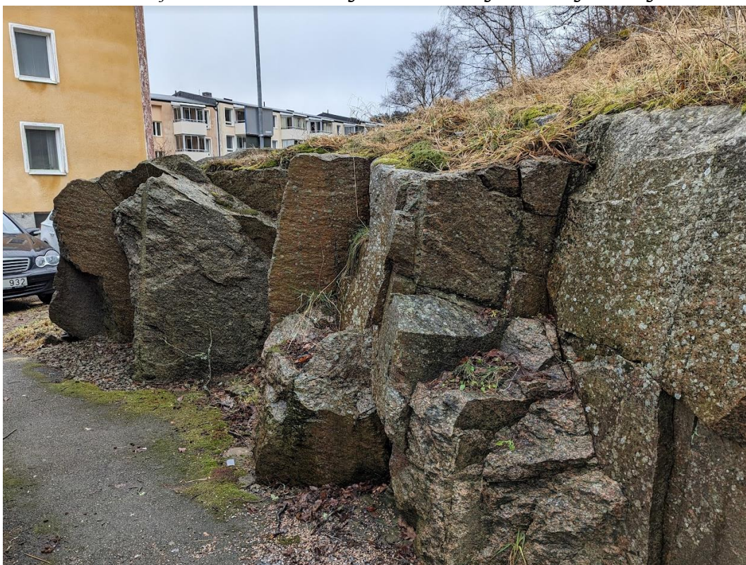
Foto 11. Mindre framsprängd bergslänt bakom sopstation i nära anslutning till den nordvästra bergslänten. Bild tagen i nordlig riktning.
