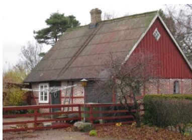
Uthuset till Tunneberga 3:9
