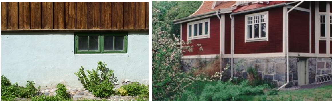
Figur 26, 27. Exempel på utformning av socklar - Slätmurad, Natursten.
