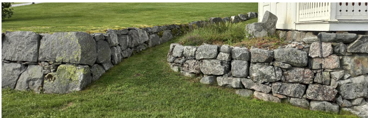
Figur 18. Foto på befintlig kallmurad mur med block intill paviljongen. (Gävle kommun, 2023-09)
