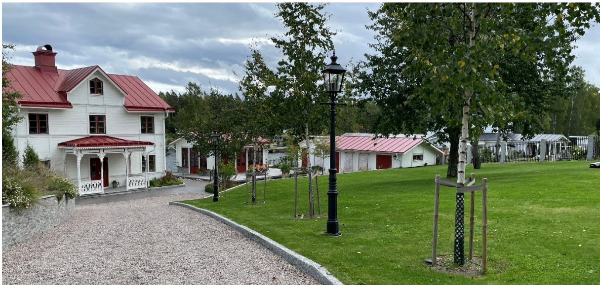
Figur 34. Foto mot huvudbyggnad, taget från parkering i väst, riktning österut. (Gävle kommun, 2023-09)
