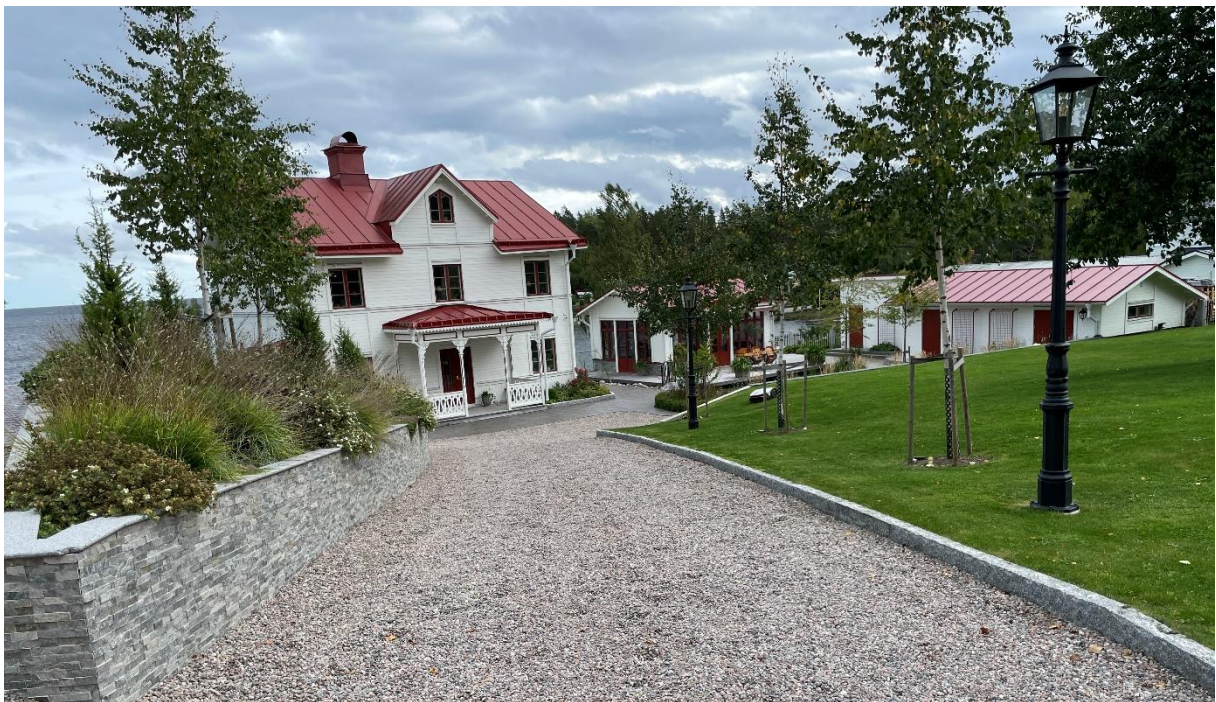
Figur 30. Huvudbyggnad sedd från infarten. Orangeri och förråd syns till höger i bild. (Gävle kommun 2023-09)
