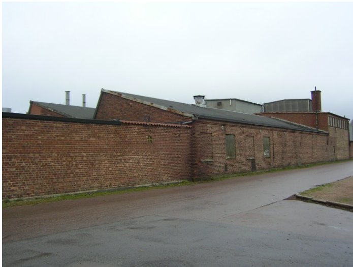
Figur 5 Omslutande tegelmur som är mycket karakteristiskt och ett miljöskapande inslag i området.
