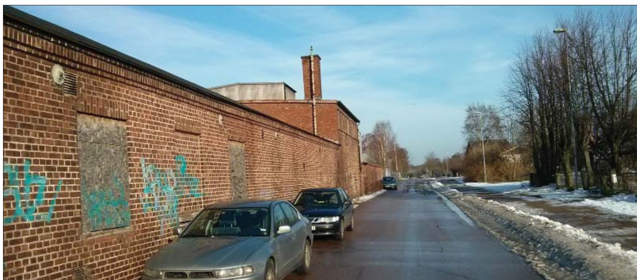
Delen av byggnaden mot gatan kan bevaras. Exempelvis kan fönsteröppningarna bevaras. Alternativt rivs hela byggnaderna och delen mot fastighetsgräns mot Bryngelshusgatan återuppförs, med eller utan fönsteröppningar.
