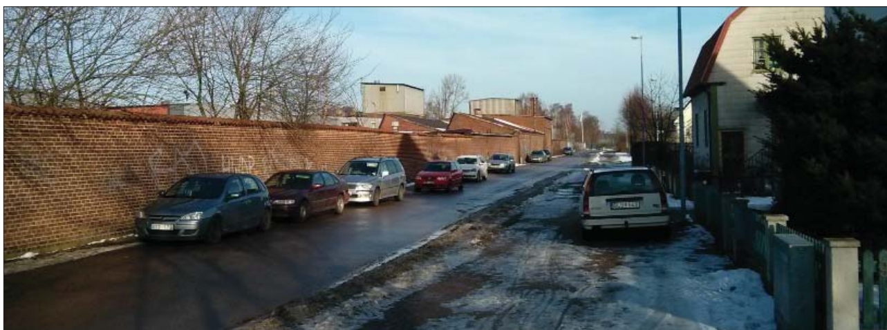
Muren sträcker sig längs Bryngelshusgatan. Längre bort i bilden syns byggnaderna som ger intryck att vara del av muren.
