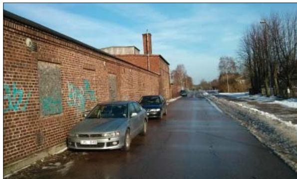
Bryngelshusgatan. GC-väg saknas. Oreglerad parkering sker längs muren.
