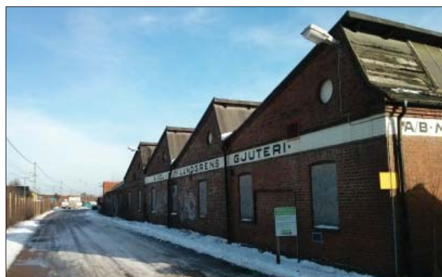
Industribyggnad med sågtandstak, uppförd 1917.
