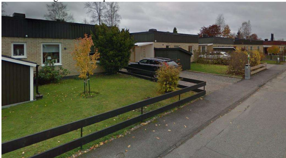
Den norra raden av vinkelhusen i ljust tegel, område 3 i översiktsbilden.
