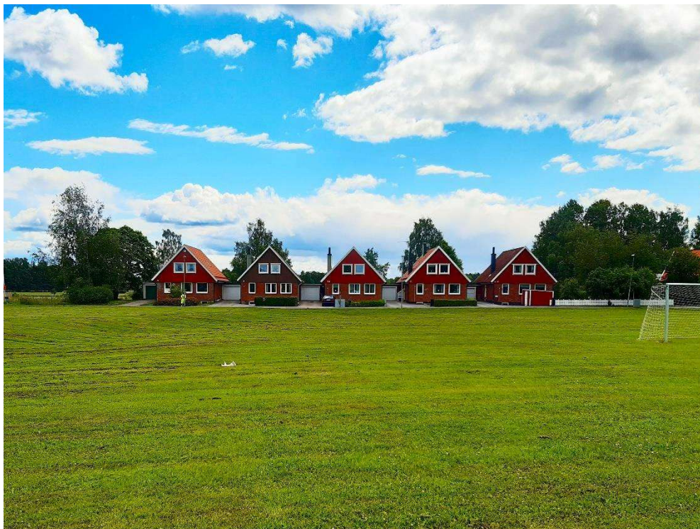
Kedjehusen i Lassas ytterkant, område 1 i översiktsbilden. Foto mot söder.
