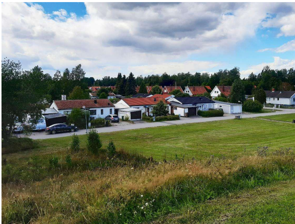
Kedjehusbebyggelsen i de centrala delarna av Lassas, område 2 i översiktsbilden.
