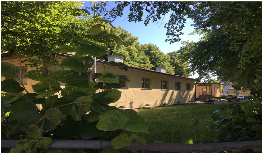
Kloakpumpverk, pumpstation för avlopp, (främst i bild) samt före detta vaktmästarbostad från sydväst. Dessa två byggnader föreslås få skydd i detaljplanen då de är kulturbistoriskt värdefulla.
