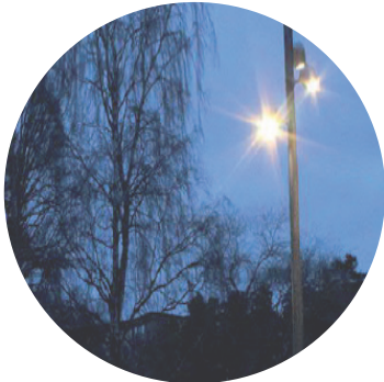
Stolpar med riktbara spotlights
