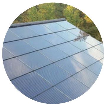
EXTERIÖR. Tak med Integrerade solceller.
