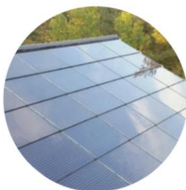
EXTERIÖR. Tak med integrerade solceller.
