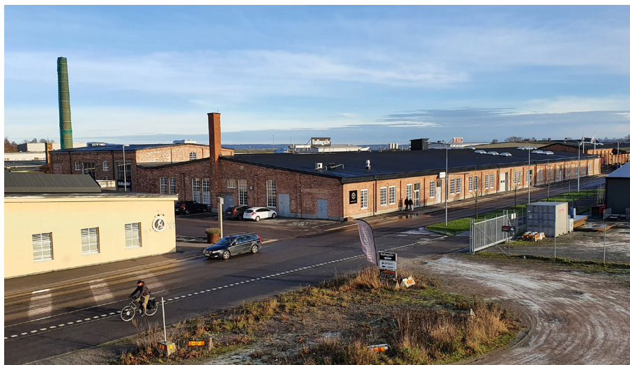
Fig. 7 Vy över fastigheten Hyveln 1 från sydväst med Sockerbruksgatan i förgrunden. (november 2021)
