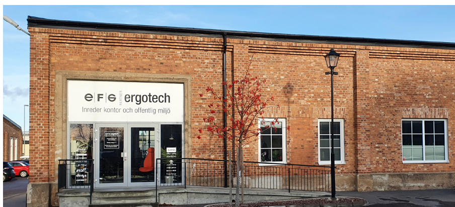
Fig. 11 Foto som visar exempel på kontrefort (vertikala strävpelare i fasaden) och takgesims (översta horisontella delen, avgränsning mellan fasad och yttertak).
