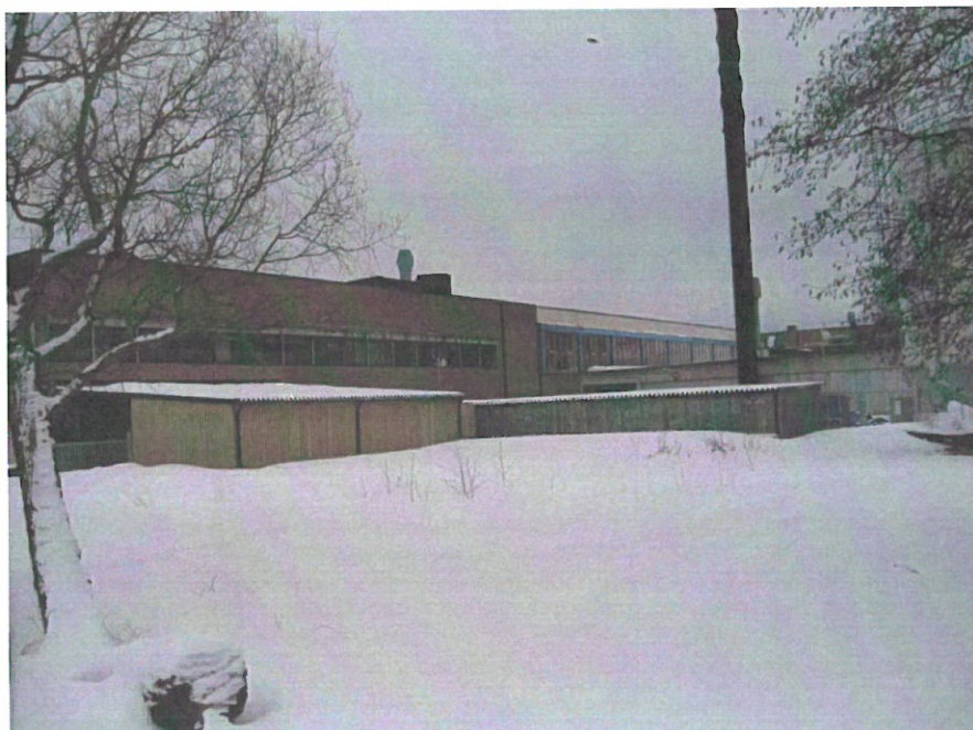
Fasad mot väster, norra delen
