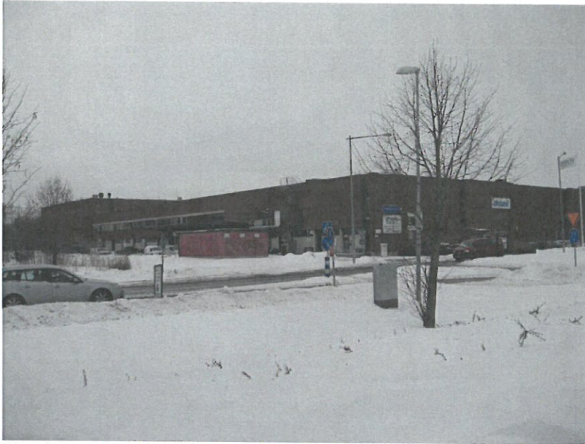
Fasad mot söder och öster. Arnöleden i förgrunden.
