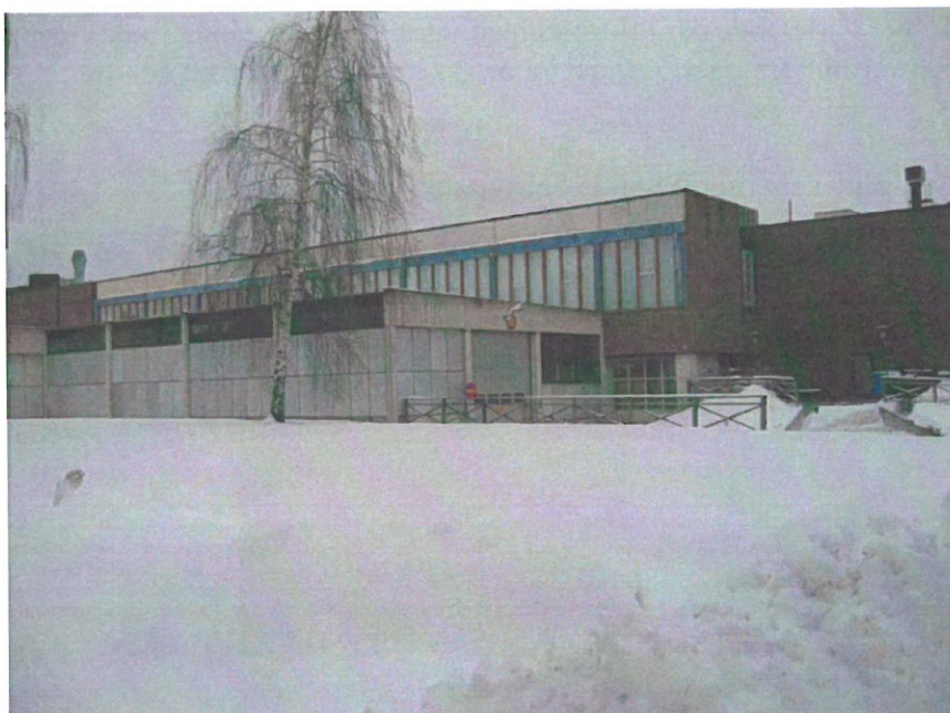
Fasad mot väster, södra delen
