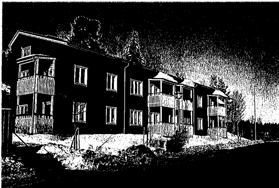
Exempel på befintlig bebyggelse på Banslättsvägen
