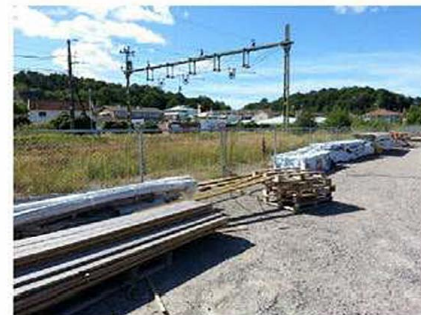
Wy mot spårområdet vid Bohusbanan
