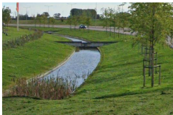
Exempel dagvattenkanal i verksamhetsområdet Hammarshus, Kristianstad. Bildkälla: Google maps 2021.
