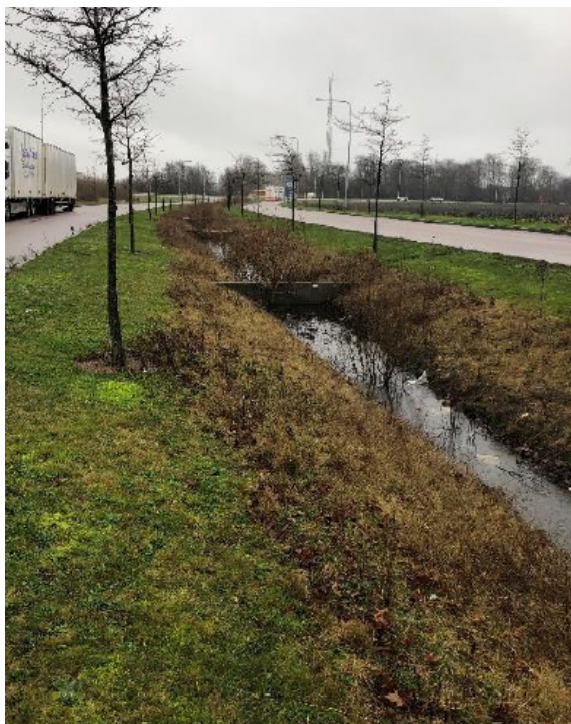
Norregårdsleden (befintlig infartsgata) söder om planområdet med dagvattendike i mitten av gaturummet. Foto: Niras.
