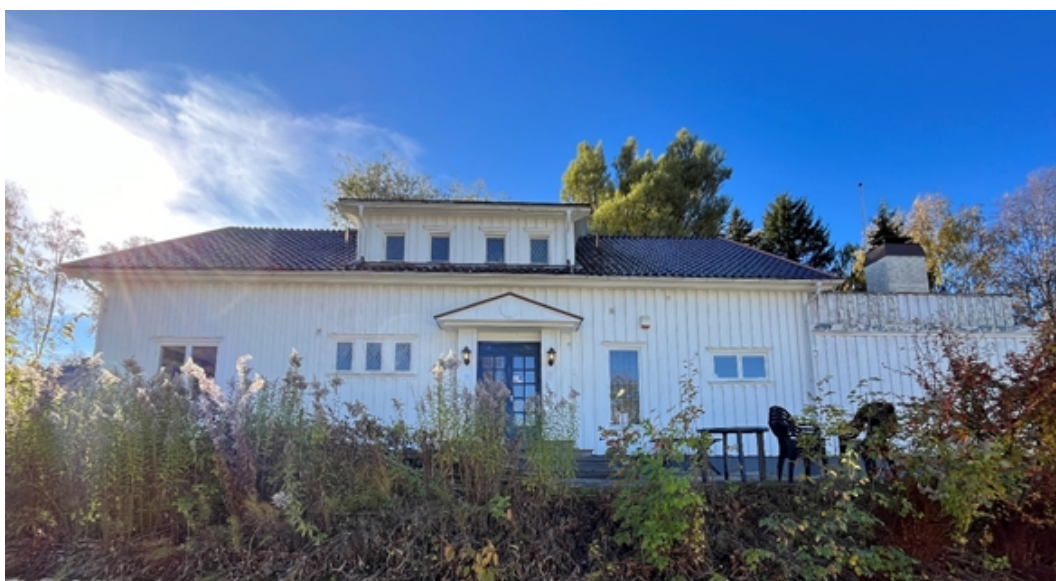
Huvudbyggnadens fasad mot öster.
