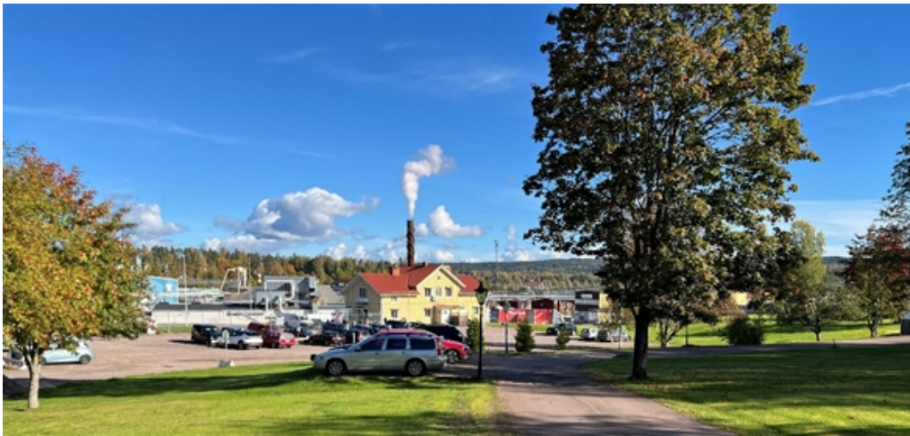
Sågverket sett från planområdet.
