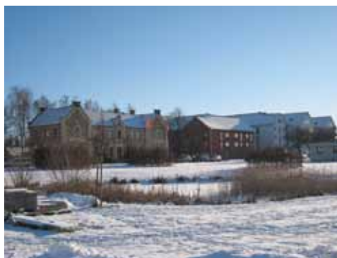
Studentparken med dagvattendammar. I bakgrunden skymtar stationshuset till Bolmenbanan.
