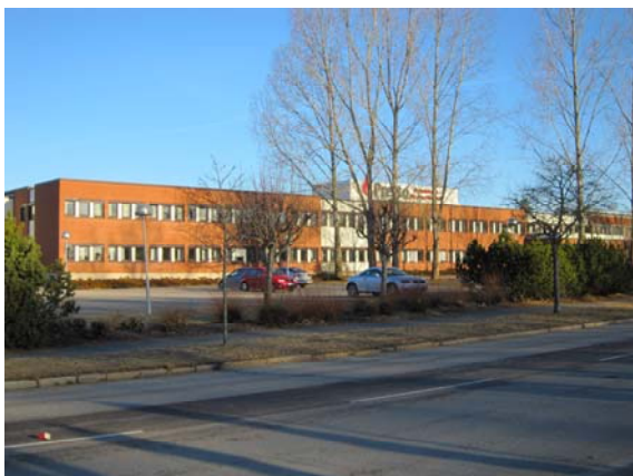
Industrifastighet väster om planområdet
