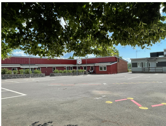
Vy mot sydöst från den asfalterade innergården
