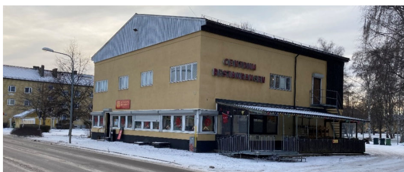
Fasad mot Järnväggsgatan i öster – foto taget från norr 2022-12-27
