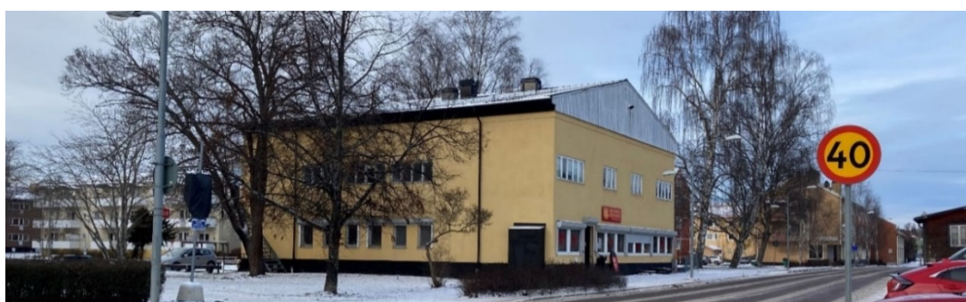
Fasad mot Järnväggsgatan – foto taget från söder 2022-12-27
