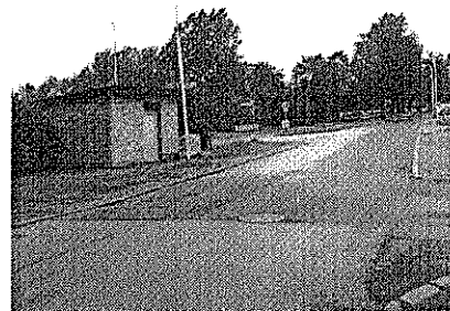
Bild 10: Södra vägen och transformatorstationen.
