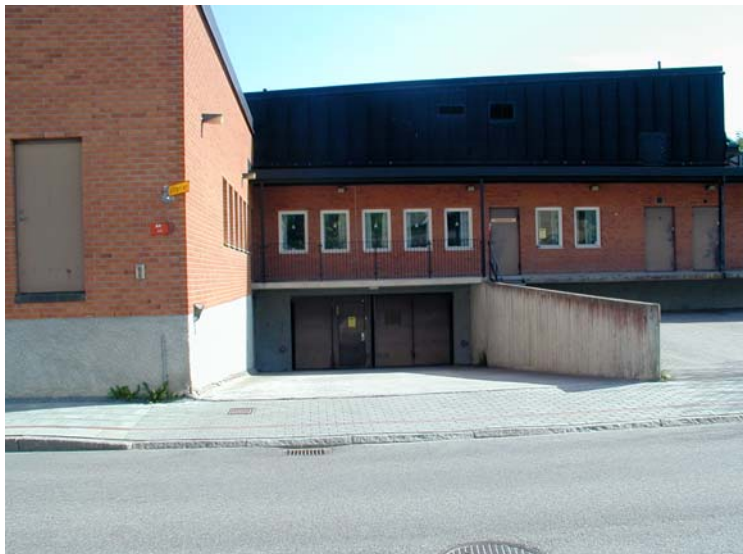
Befintlig nedfart vid Sandgatan.
