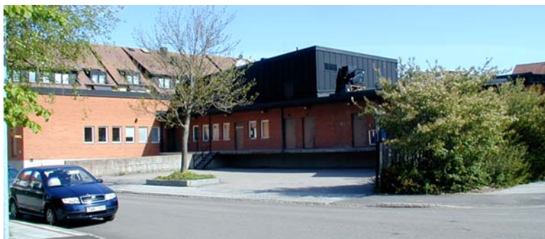
Lastkajen med uppställningsyta för fordon vid in- och utlastning.
