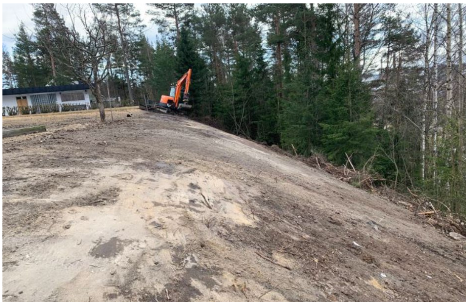
Figur 3. Foto på genomförd schaktning av slänkrönet. Källa: Nybergs Fastigheter och Förvaltning AB.
