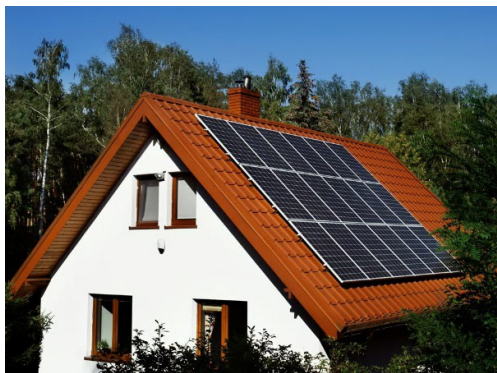
Exempel på utanpåliggande solenergianläggning.
