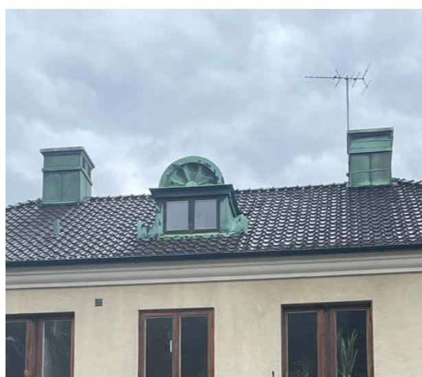
Bild. Takkupa och skorstenar i koppar.
