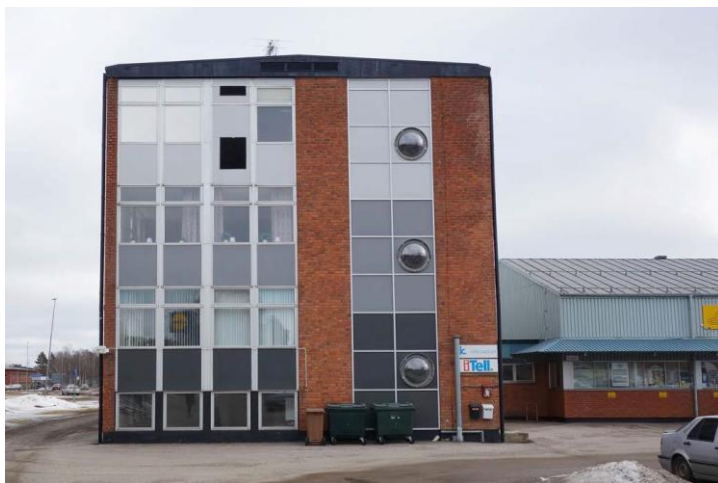
Trevåningsbyggnadens västra fasad. Här syntes ursprungligen trapphuset bakom en glasvägg. Idag är ytan täckt med skivor. De sfäriska fönstren är ett säregnet tillägg.
