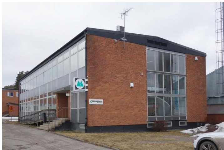
Kontoret är den byggnad som förändrats minst sedan uppförandet i början av 1960-talet. Här syns glasväggen till trapphuset. Ett likadant fanns tidigare även på trevåningsbyggnaden. Fasadskivorna, som troligen är tillverkade av Eternit, var ursprungligen målade turkosblå.
