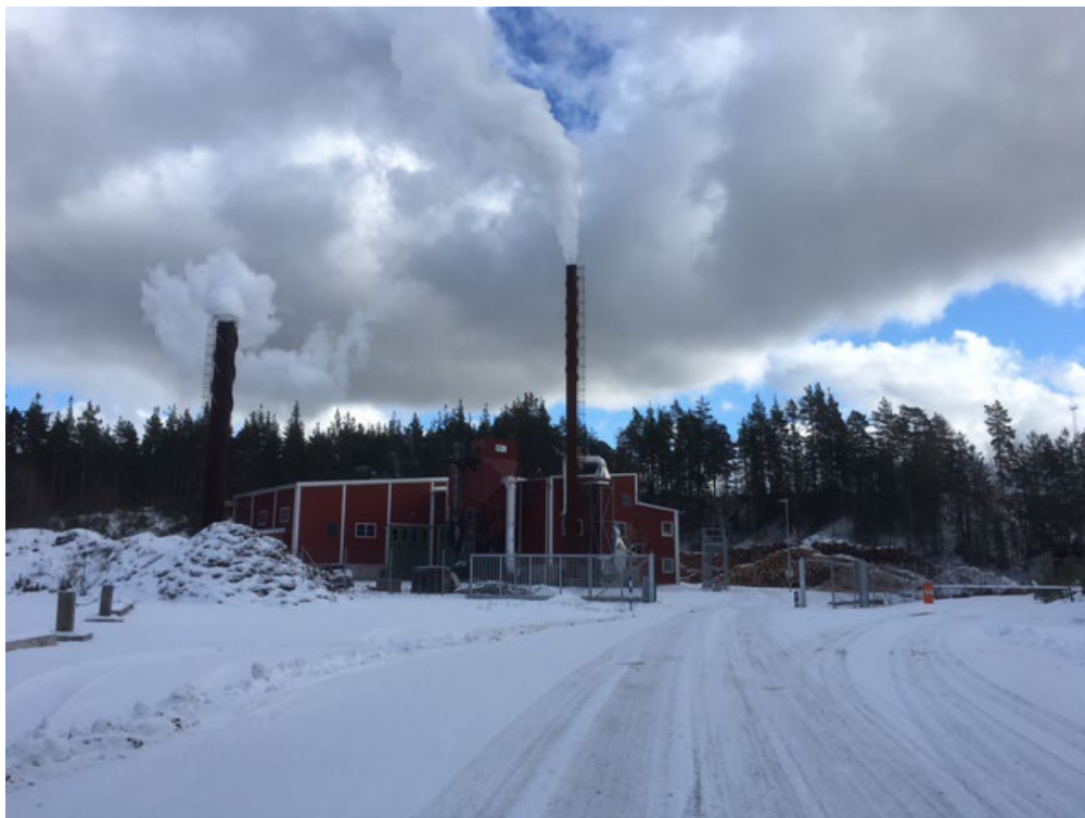
Figur 5. Befintlig fjärrvärmelanläggning med tillhörande skorstenar.
