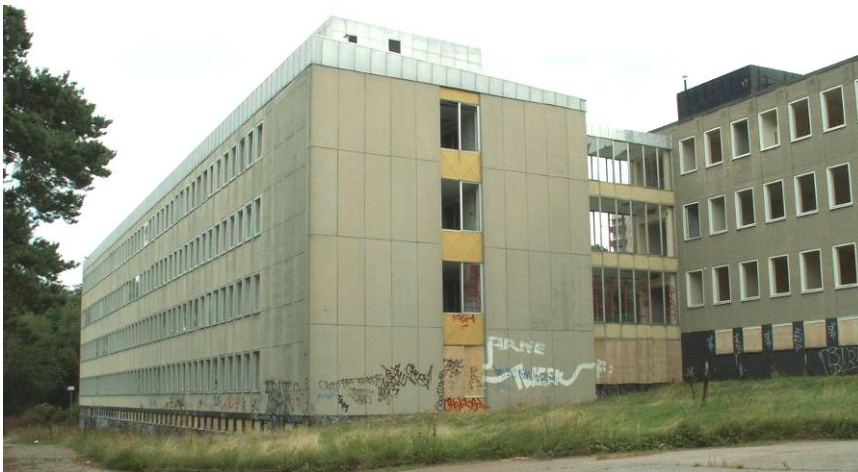
Milostabsbyggnaderna innan rivning. Byggnaderna stod tomma under en längre tid innan de revs.
