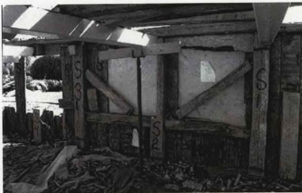
Bild 4. Lerhamnshuset nr 9. Bild från demonteringen.
