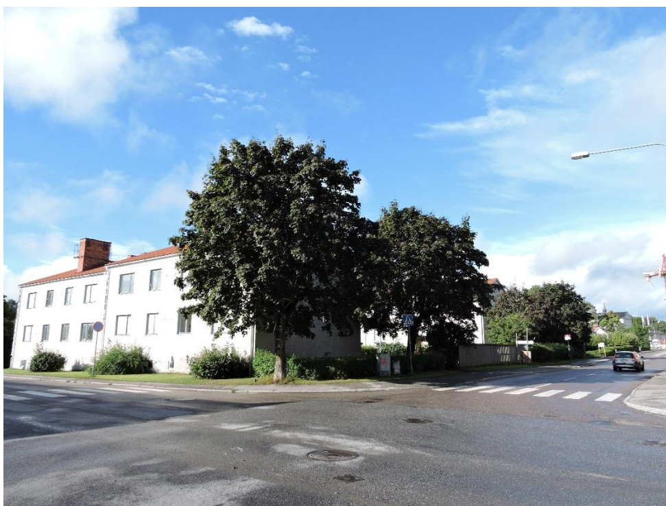
Figur 13. Befintliga flerbostadshus i korsningen Vegagatan/Hamnvägen. Foto: Kristina Nitsch, Sweco.
