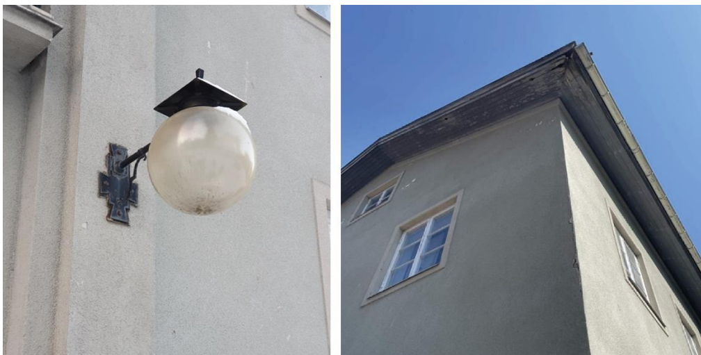
Figur 14. Armaturen vid huvudentrén och till höger takfoten.
