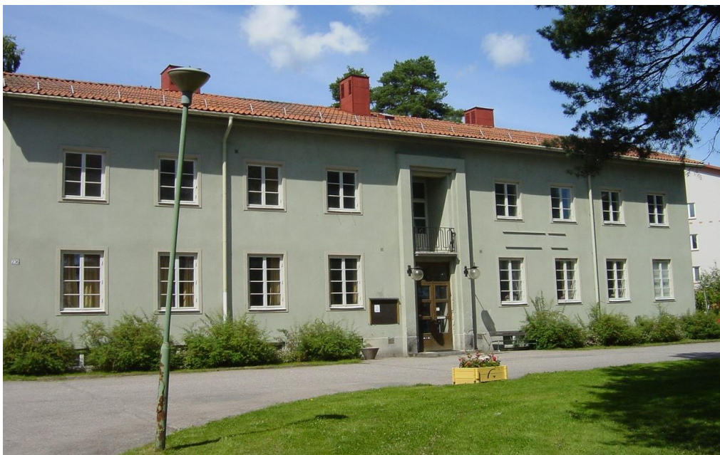
Figur 22. Det före detta kommunhuset sett från söder.
