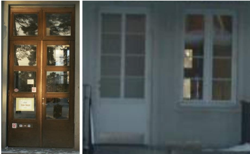
Figur 16. Entrédörren och dörr mot norr som är väl anpassad till våningens fönster i sin utformning.
