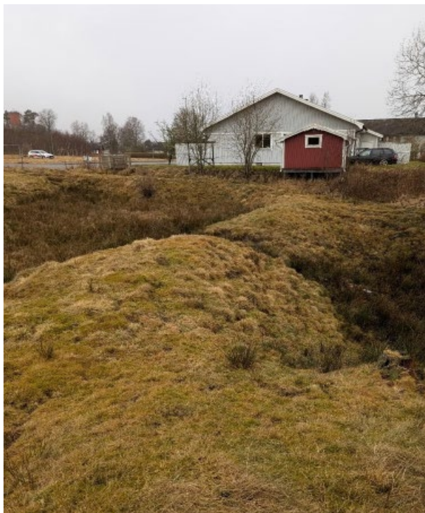
Bild på jordvall tagen vid platsbesök 2025-02-27.
