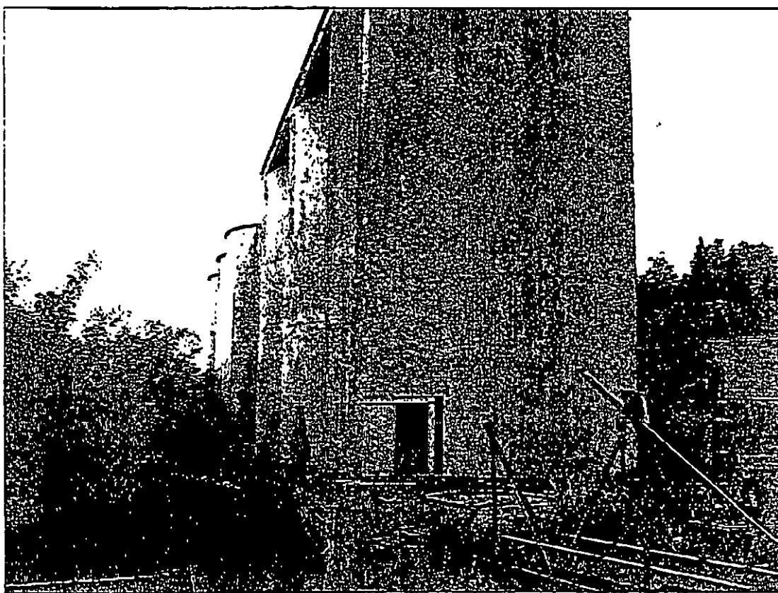
»Silosarna« från norr
