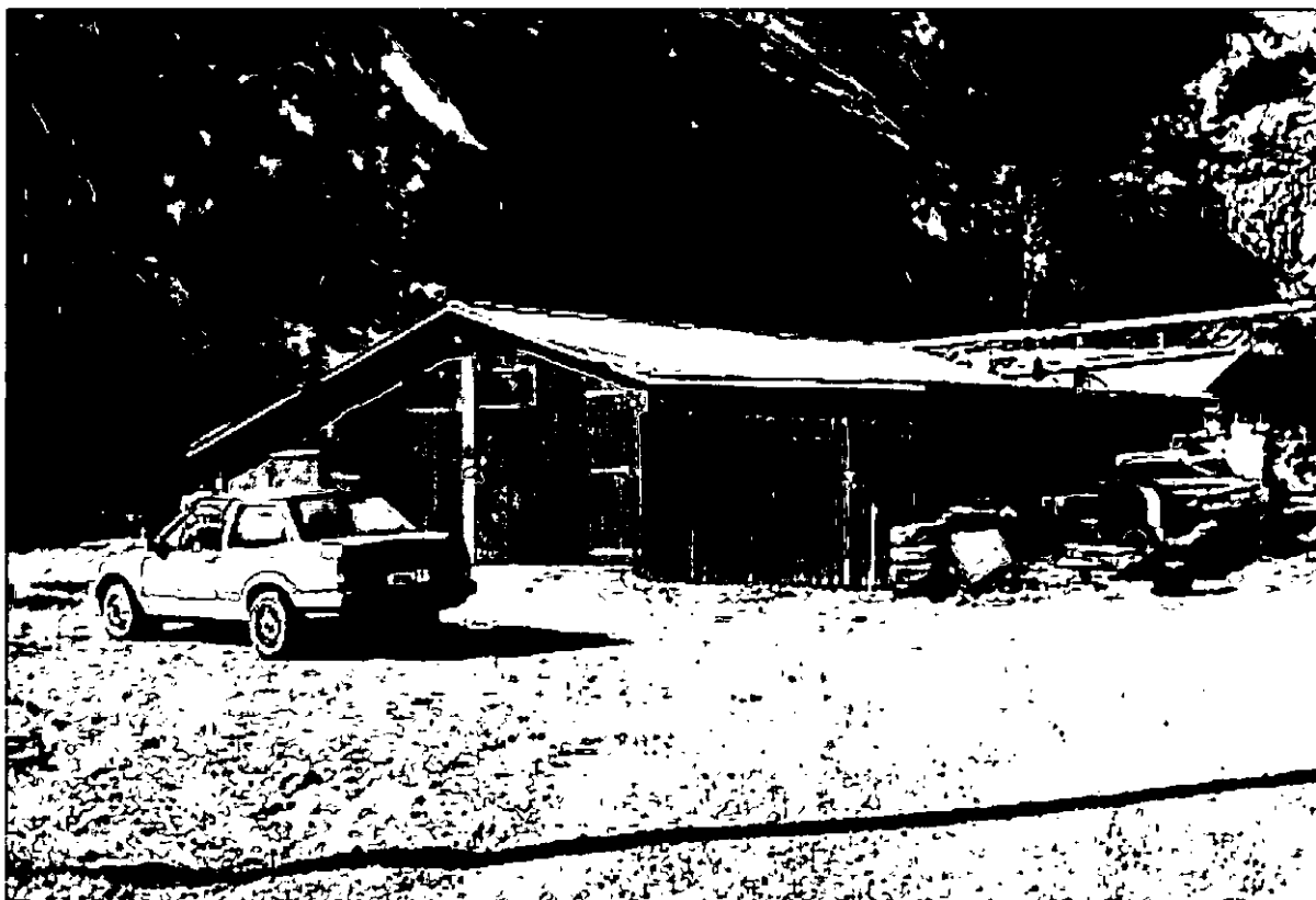
Uthusbyggnaden från nordost
