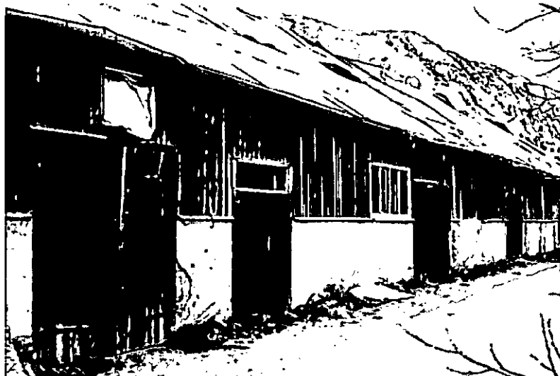
Till vänster Utsnitt av östra fasaden Nedan: Östra fasaden. Man ser de inmurade trästolparna där putsen fallit bort
