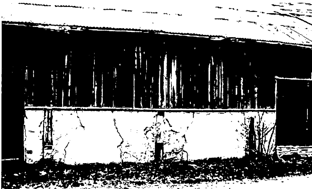
Till vänster Utsnitt av östra fasaden Nedan: Östra fasaden. Man ser de inmurade trästolparna där putsen fallit bort
