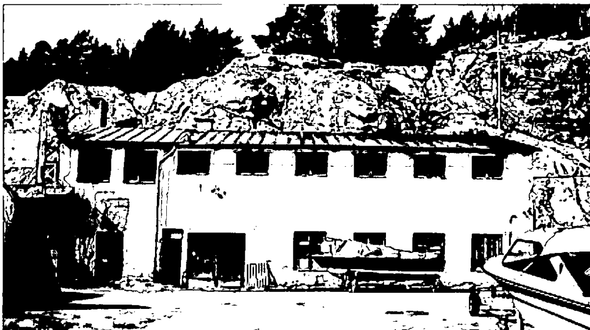
Tvåvåningsdelen från öster. I övervåningen har det varit laboratorium och omklädningsutrymmen.
