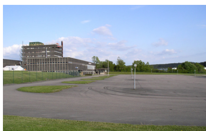
Västra planområdet med den stora parkeringsplatsen. Nordverksbyggnaden med kontorshuset och matsalen i fonden.
