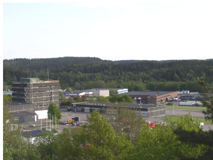
Utsikt över västra planområdet och Nordverksfastigheten från Kurödsbergen.
