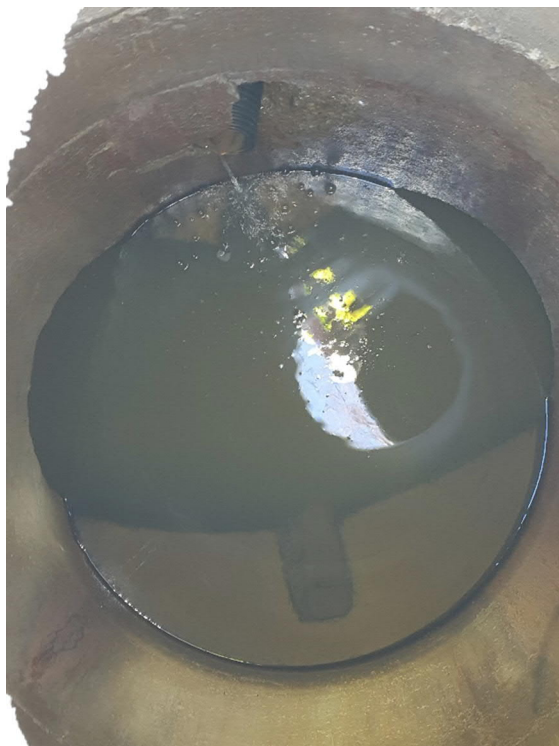
Figur 11 Fotografi på brunn. I överkant syns en inkommande ledning som avleder vatten från området.
