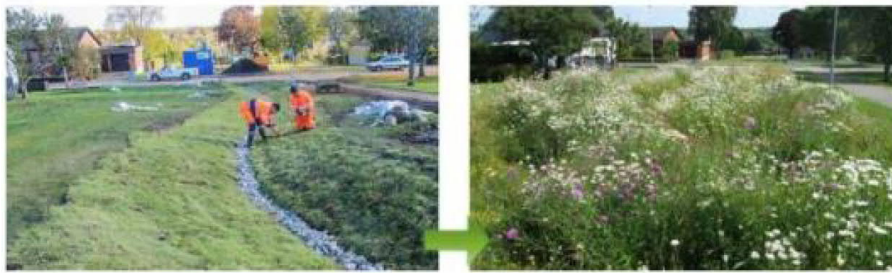
Figur 16 Exempel på svackdike uppbyggt med fuktängsmattor vid anläggning och efter 1,5 år. Bildkälla: vegtech.se.
